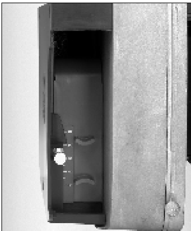
Рис. 8: Шумопоглотитель воздухозаборника Logatop GE1H, а так же заслонка со шкалой и фиксатором
